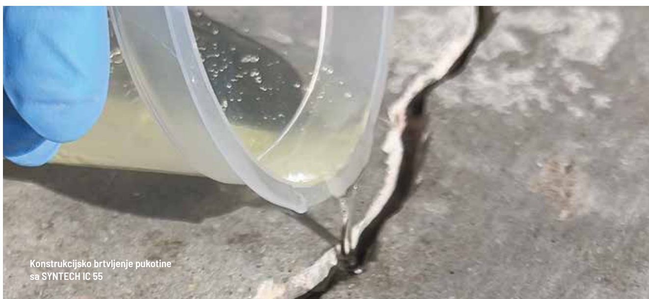
Postavljanje trake FILTENE FONDO GIUNTO u dilatacijski spoj
